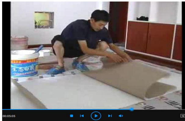
△墙面壁纸施工教学视频
